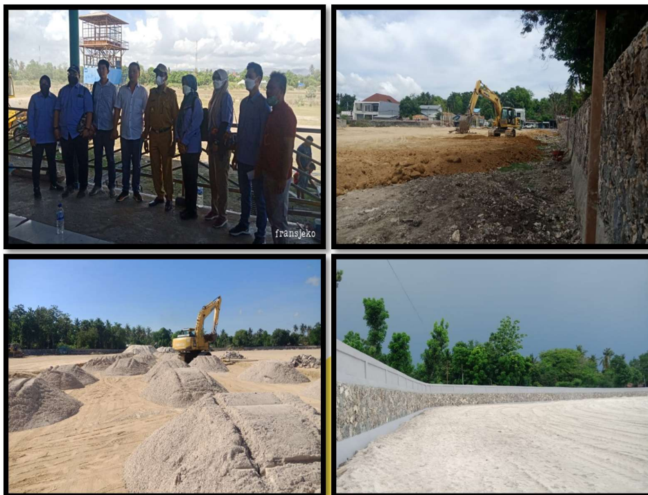
Gambar 11. Pembangunan Lapangan Pacuan Kuda NTT
