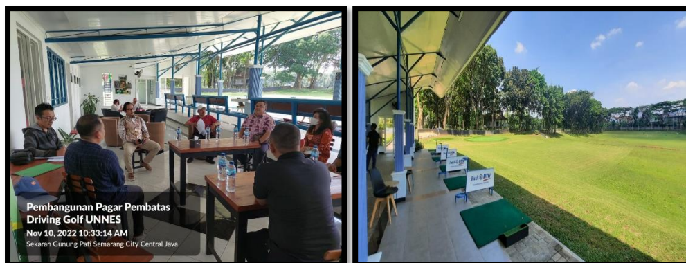
Gambar 9. Pembangunan Pagar Driving Golf UNNES
